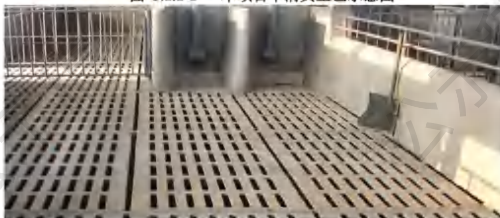
图 3.2.2-3 同类型项目猪舍地板为全漏缝示意图
